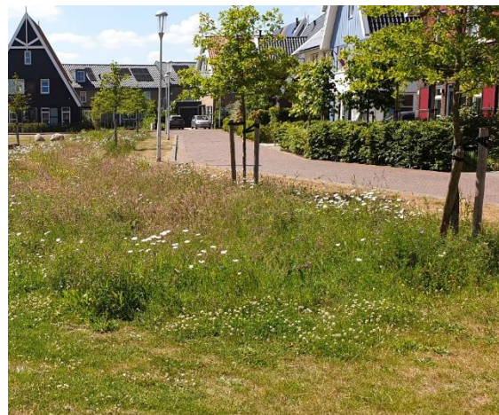
Wadi: verlaging in het landschap waar regenwater in wordt opgevangen
